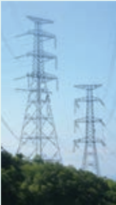
▲ 基幹系送電線建設工事
