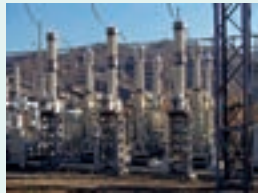
▲ 基幹系変電所204kV 複合開閉装置取替工事
