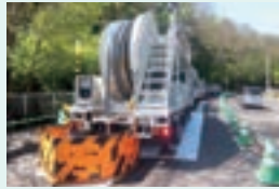
▲ ケーブル張替工事
