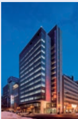
▲ 明治安田生命札幌大通ビル 新築工事
