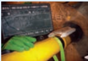
▲ ケーブル実挿管路点検用カメラ 架台・鞘管挿入工法
