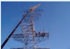
▲ JR上幌向支線支持物建替工事
