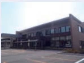
▲ 北海道大学獣医学部動物医療センター 新営電気設備工事
