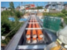
▲ はまなす地中線新設のうち管路工事
