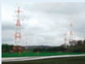
▲ 岩松線西音更変電所引込工事
