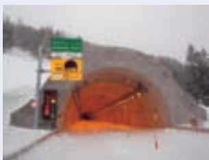
▲ 旭川紋別自動車道上川町トンネル
