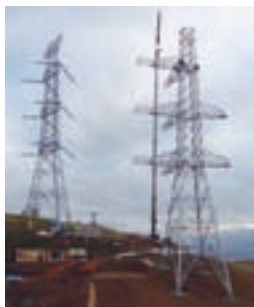
泊幹線移設及び関連除却工事
