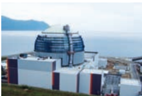
泊発電所3号機（全景）
