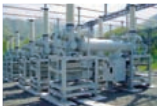
西野変電所275kV連変C増設工事
