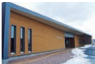
新寿都町立診療所建設電気工事
