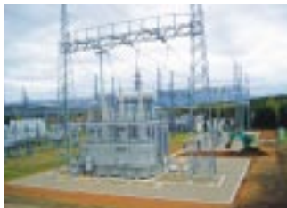
大野変電所連変増設工事
