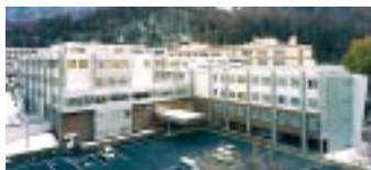
慈啓会病院 近代化整備事業工事
