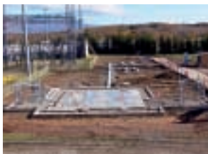
大野変電所連絡用変圧器増設工事
