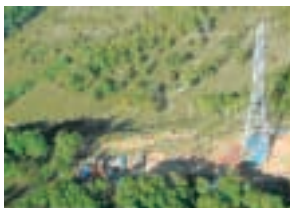
後志幹線架線工事
