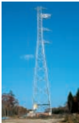
道央南幹線新設工事のうち第3次鉄塔工事
