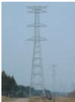
道央南幹線 架線及び鉄塔工事
