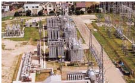
北海道電力㈱ 南札幌変電所連変増設工事
