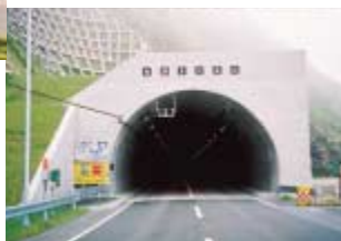
えりも町白浜トンネル
