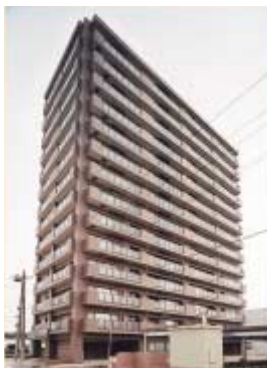
クリーンリバー フィネス北30条 エレベーター
