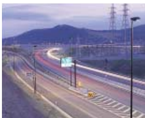
北海道縦貫自動車道 旭川鷹栖IC
